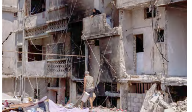
لبناني ينقل مواد بناء خلال ترميم منزله الذي تضرر جراء غارة إسرائيلية استهدفت مدينة صور في جنوب لبنان (رويترز)
